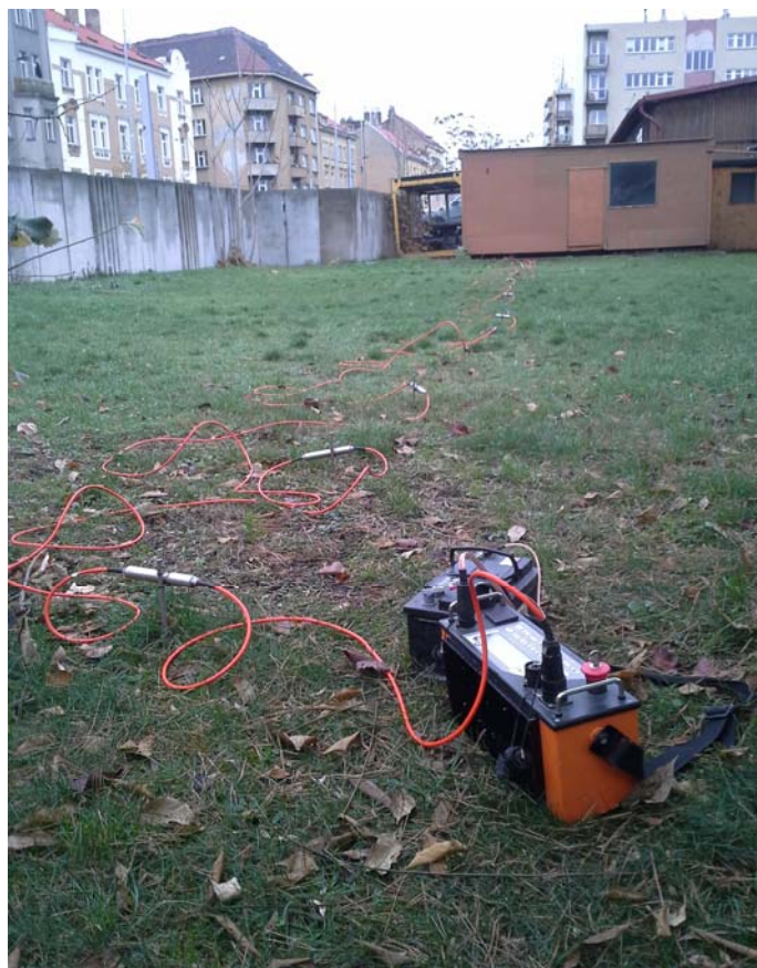
Obr. 2: Měření odporové tomografie přístrojem ARES
