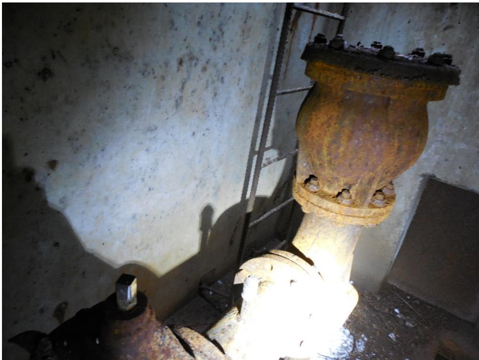
Pohled do vzdušnické šachty A716 směrem od OC DN350 na stávající vzdušník
