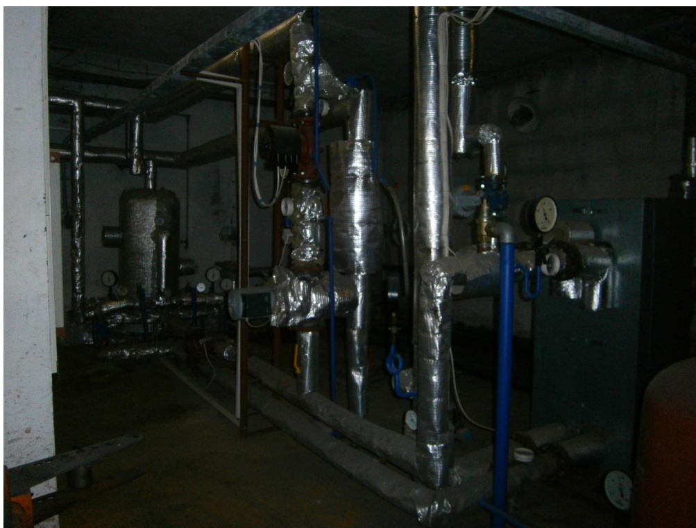
Obr. 4 – Výměňíková stanice VS H1.
