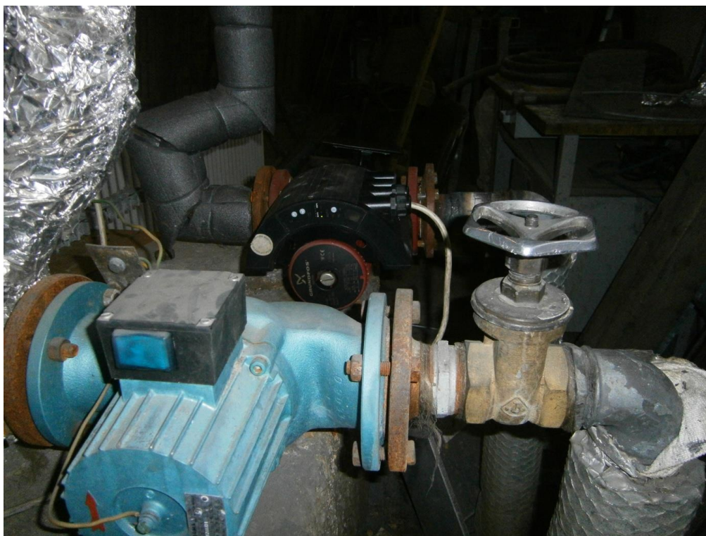
Obr. 5 – Cirkulační čerpadla VS H1.
