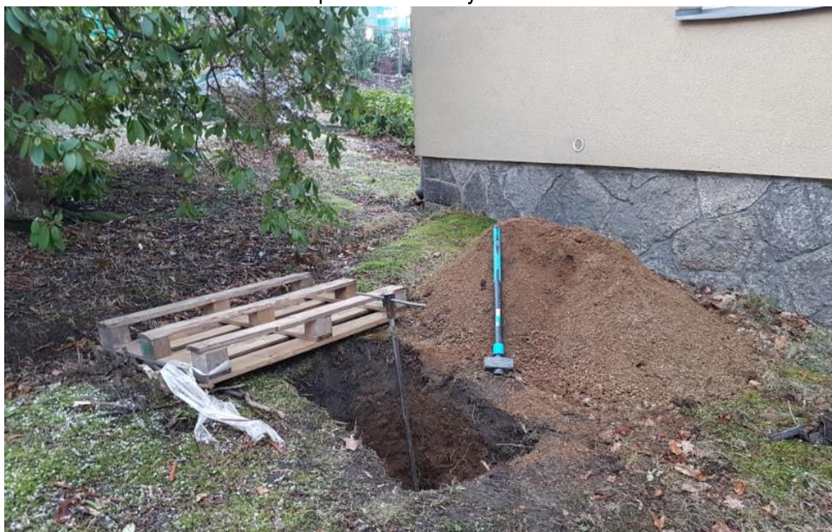
provádění sondy KS1
