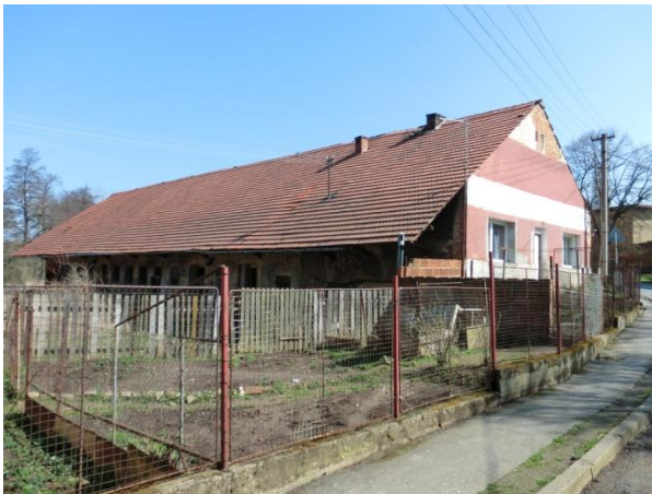
Objekt chlévů a byt
