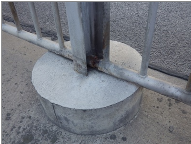
Zabetonování slouků zábradlí na mostě.
