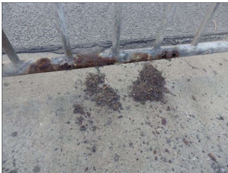
Detail korodujícího zábradlí.
