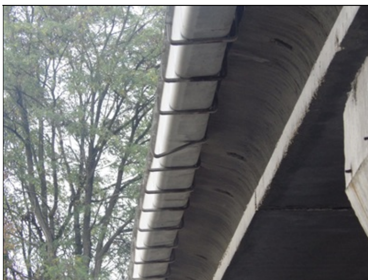
Žlab odvodnění a jeho uchycení.
