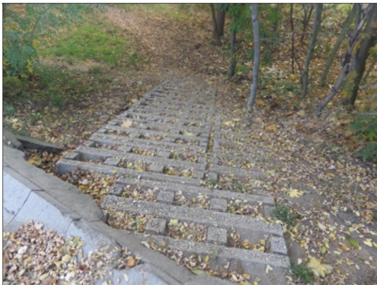
Zatrávňovací dlaždice jako zpevnění a zároveň revizní schodiště.
