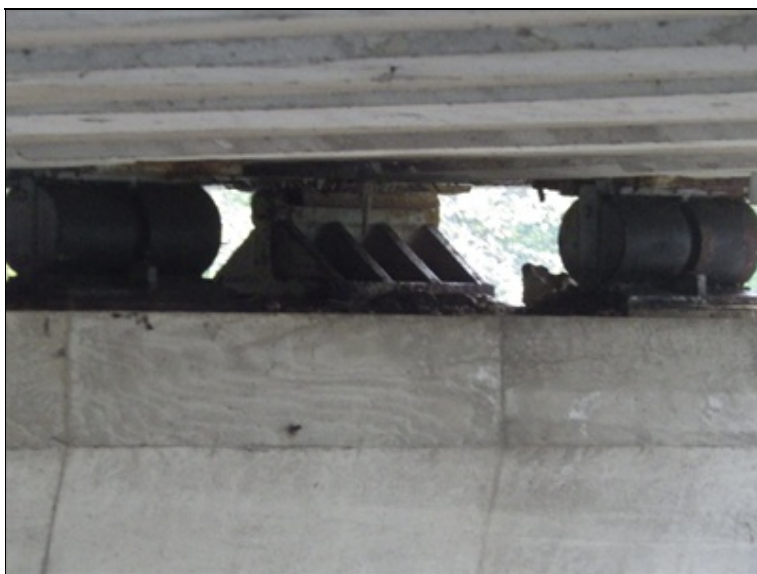
Ložiska na pilíři P2.
