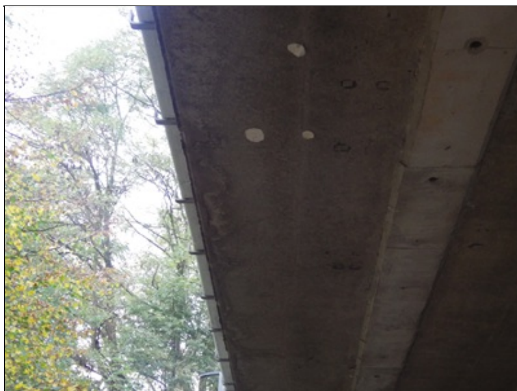
Pravá konzola s odvodňovacím žlabem na boku konstrukce.
