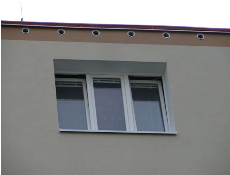
Obr 5 : Ilustrační ukázka upravených plastových krytek (krytka má vyříznuté lamely a je na spodním okraji zdrsňená).
