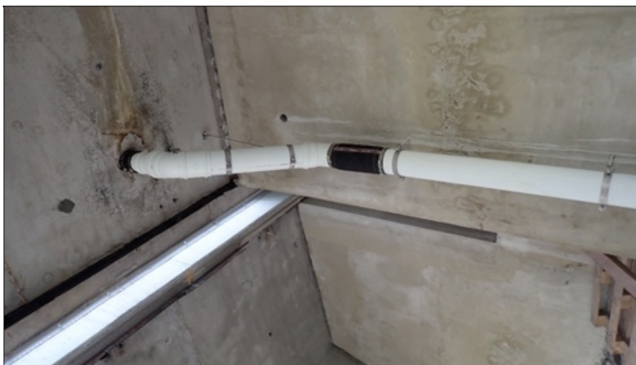
Nový svod. Znamky zatékání jsou z doby před opravou
