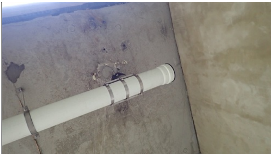
Známky zatékání na spodním líci NK. Stopy průsaků jsou z doby před opravou.
