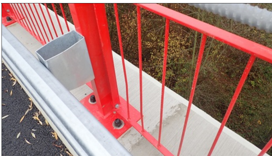
Děformovaná svislá výplň ZS na LS mostu
