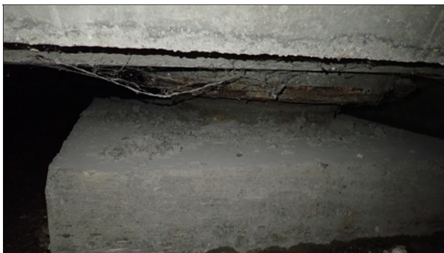
Koroze ložisek. Chybí prachovky u P0
