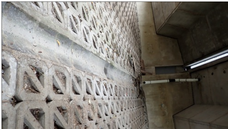
Rozvolněné opevnění pos svislím svodem u OP0
