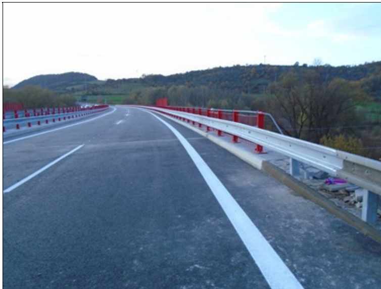
Odvodňovací proužek
