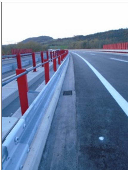
Odvodňovací proužek
