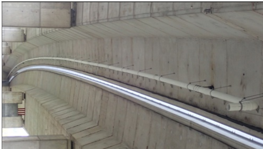
Pohled na spodní stranu konzol a podélný svod
