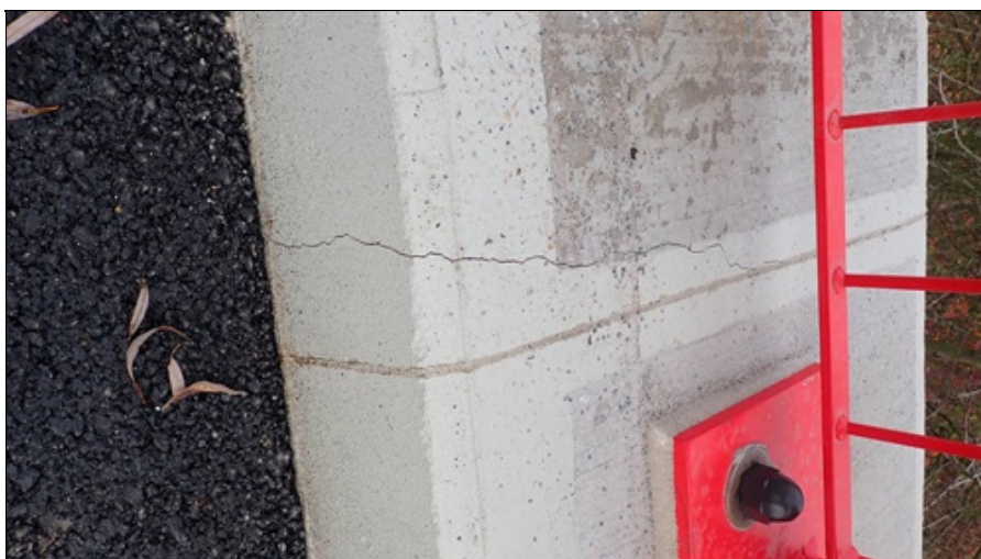
Lokálně smršťovací trhlinky
