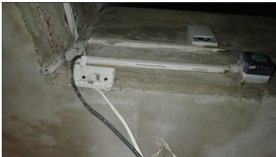
Poškozený senzor zabezpečení opěry P0
